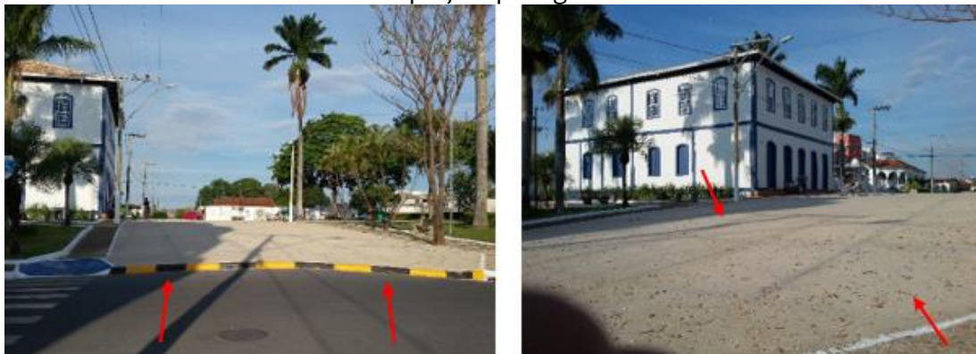
Imagem 07: Detalhe do fechamento da Rua Otávio de Brito com sinalização de elevação de calçada. Nivelamento feito junto à Praça Monsenhor Thiago, dando continuidade à mesma, sem projeto paisagístico.
