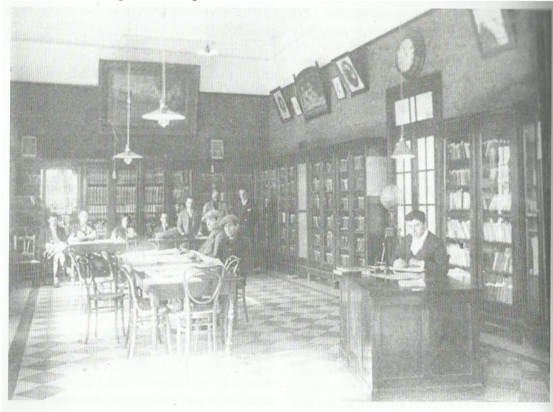
Imagem 1: Fotografia da Sala de leitura da Casa del Pueblo
