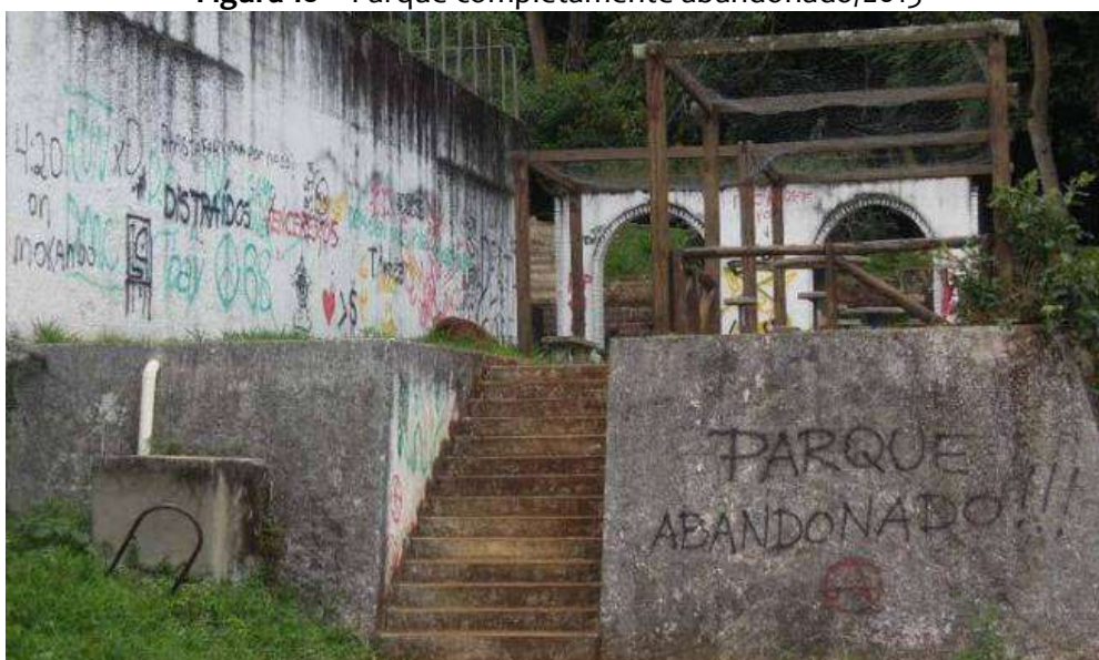
Figura 10 – Parque completamente abandonado/2013
