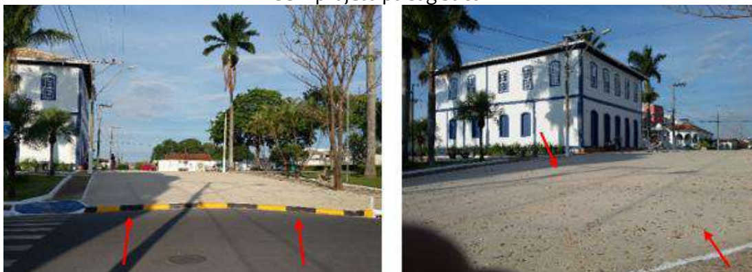
Imagem 07: Detalhe do fechamento da Rua Otávio de Brito com sinalização de elevação de calçada. Nivelamento feito junto à Praça Monsenhor Thiago, dando continuidade à mesma, sem projeto paisagístico.
