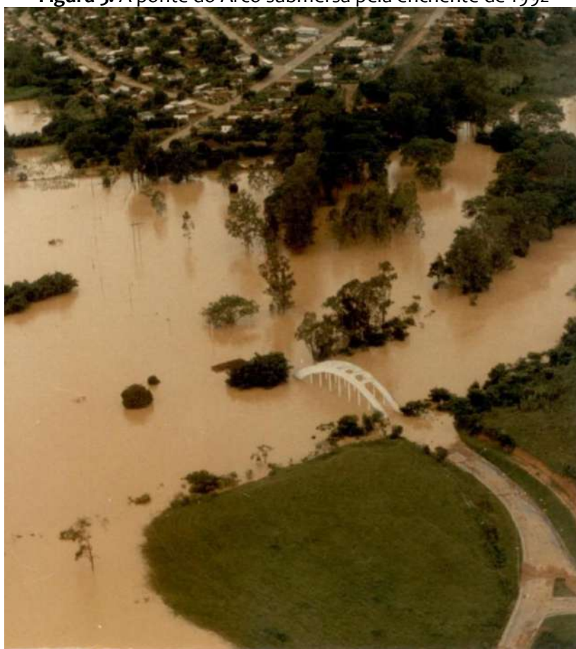
Figura 5: A ponte do Arco submersa pela enchente de 1992
