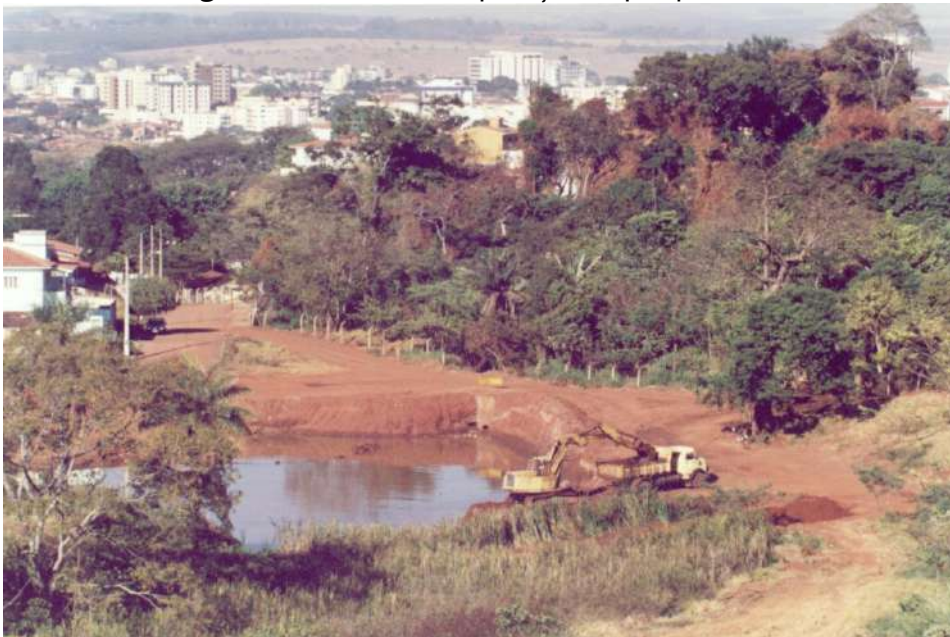
Figura 6 – Obras de recuperação do parque/2004
