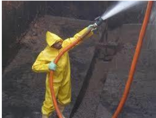
Figura 1 — Limpeza de um decantador
