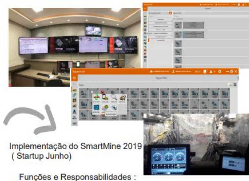
Figura 3: Sala de Controle Operacional em 2020
