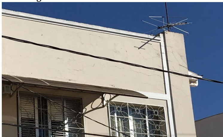
Figura 2 – Fissuras em coberturas cerâmicas
