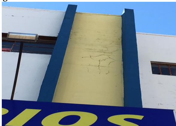
Figura 6 – Fissuras em cobertura de fibrocimento
