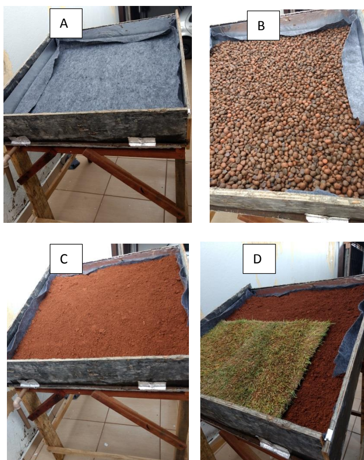
FIGURA 1. Foto A – Inserindo manta geotêxtil; Foto B – Camada de argila expandida; Foto C – Substrato; Foto D – Grama Esmeralda
