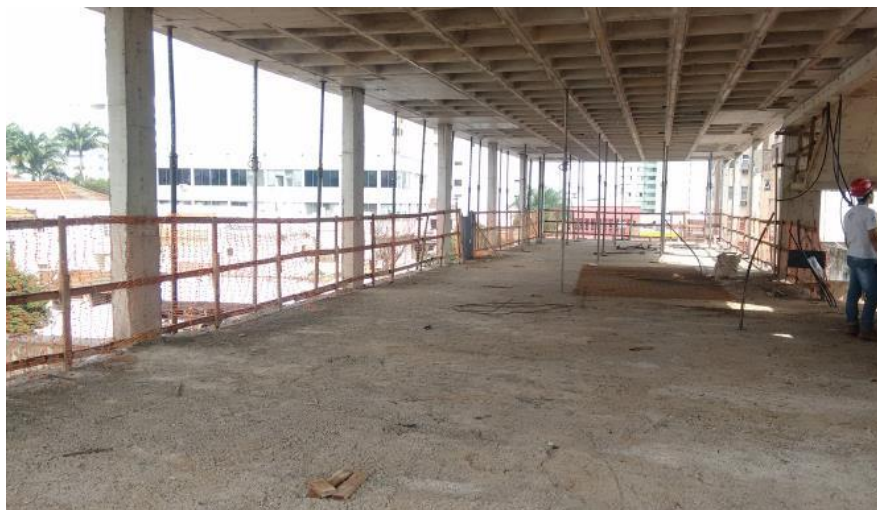
FIGURA 8: Pavimento tipo após a limpeza
