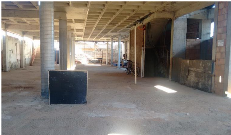
Figura 6. Pavimento térreo após limpeza
