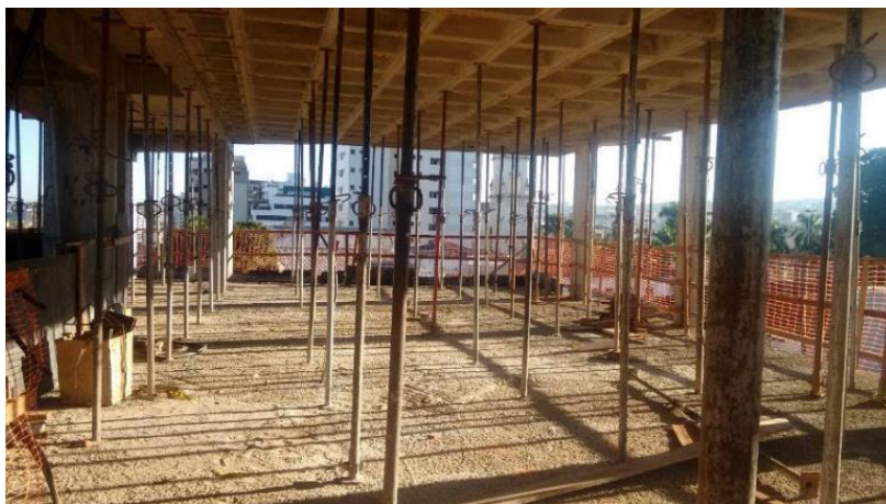
FIGURA 7. Pavimento limpo e organizado após a aplicação do senso de limpeza
