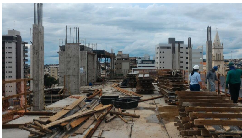
FIGURA 3. Situação inicial do canteiro de obras
