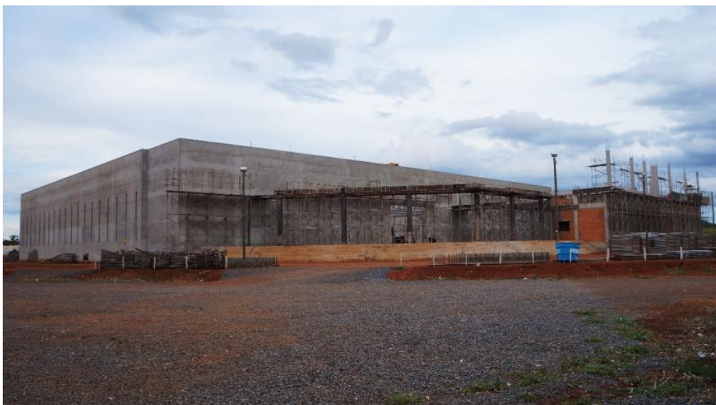
FIGURA 2. Obra do CCE atualmente (março de 2018)
