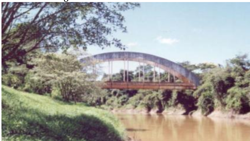
Figura 8 - Ponte sobre o rio Paranaíba
