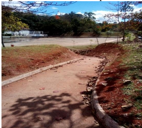
Figura 5 – Acesso em rampa acessível
