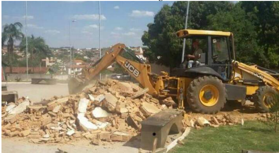
Figura 3 - A demolição da casa efetivada por funcionário da Prefeitura Municipal de Presidente Olegário.
