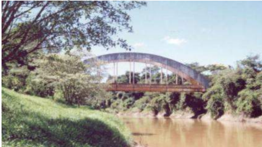
Figura 8 - Ponte sobre o rio Paranaíba
