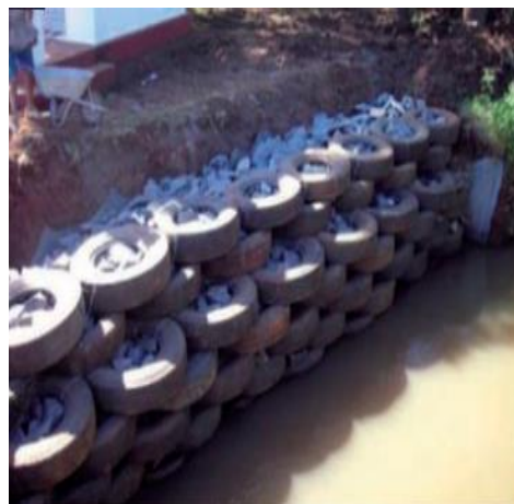
Figura 9: Estrutura de pneus executada
