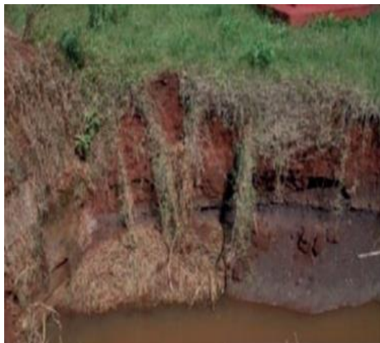
Figura 6: Talude erodido
