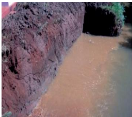
Figura 8: Abertura da vala
