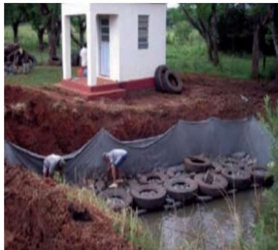
Figura 7: Muro em execução
