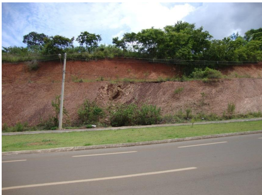
Figura 17 - Prolongamento da Avenida Fátima Porto
