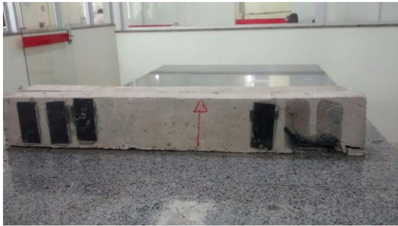
FIGURA 10. Placas de laminado de carbono totalmente desprendidas
