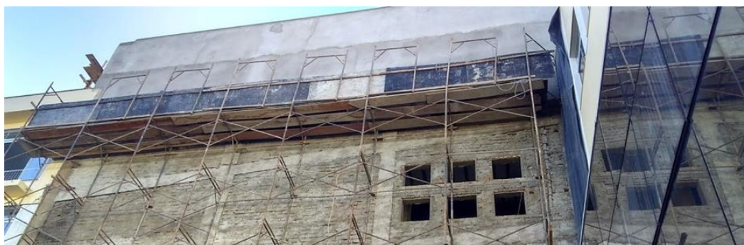
FIGURA 1. Andaime na reforma no Bloco A (Rodrigues, 2017).
