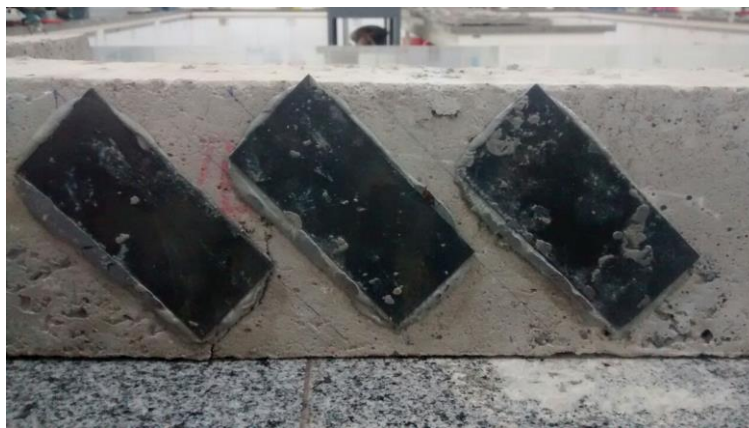
Figura 11. Rompimento da viga com reforço a quarenta e cinco graus ( 45^\circ )
