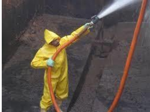
Figura 1 — Limpeza de um decantador
