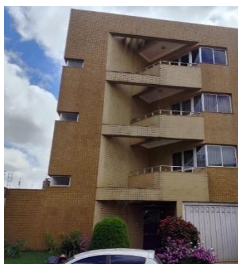
(a) Vista da fachada
