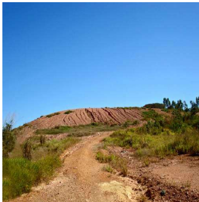
Erosões diagnosticadas nos taludes do antigo lixão do município de Patos de Minas (MG).
