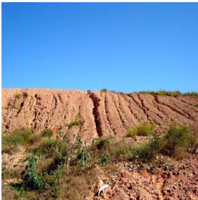
Erosões diagnosticadas nos taludes do antigo lixão do município de Patos de Minas (MG).
