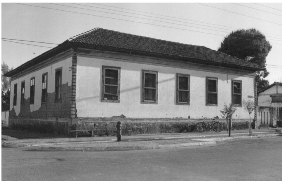
Residência do Major Jerônimo Dias Maciel, na Rua Padre Caldeira, 156, Patos de Minas-MG. Demolida em 2005.
