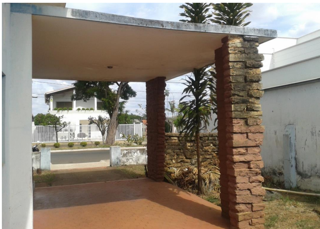
FIGURA 8. Casa Mesquita Passos. Abrigo do automóvel incorporado ao volume da edificação. A laje plana assente em pilares de pedra apresenta singular configuração. Matéria e técnica se apresentam como de fato são, expondo a verdade dos materiais. Foto do autor. 18 de julho de 2014.
