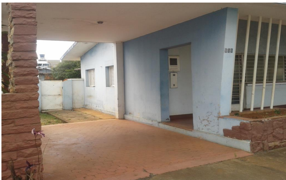
FIGURA 4. Casa Mesquita Passos. Abrigo do automóvel coberto por laje plana. Pilotis afunilados na base e discretas colunas em tubo redondo de aço discretamente inclinados. Foto do autor. 18 de julho de 2014.
