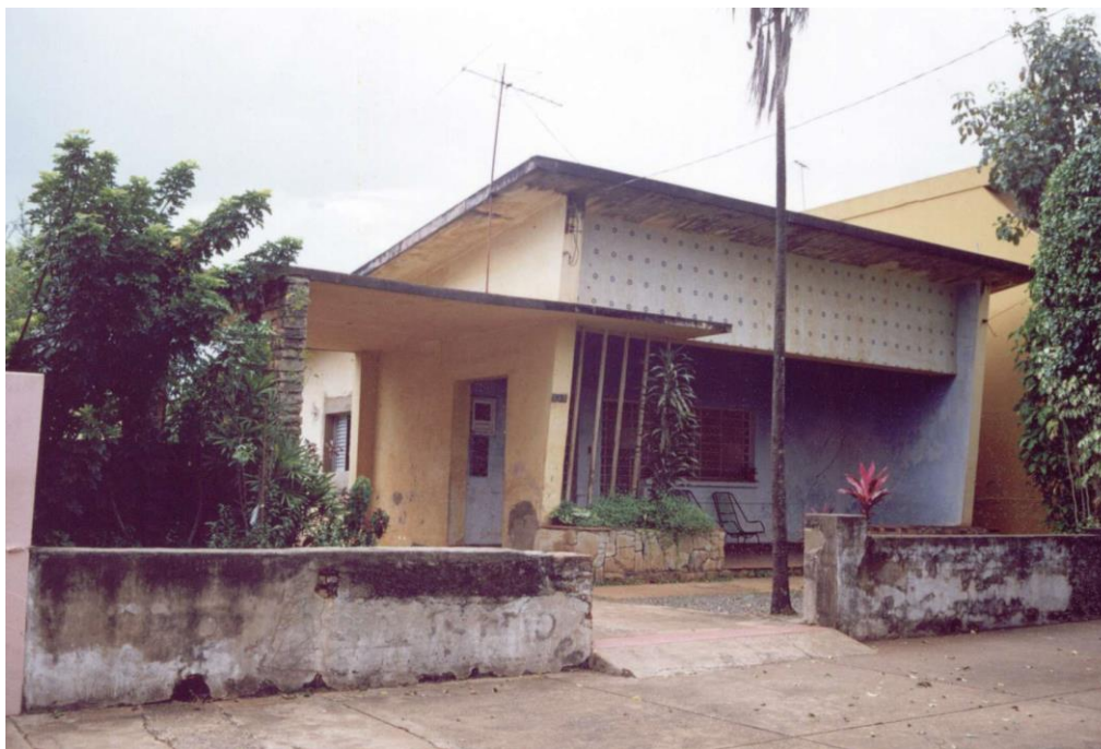
FIGURA 1. Casa moderna Mesquita Passos. Fonte: IPAC – Inventário de Proteção de Acervo Cultural - adoc-pm Arquivo da Cidade de Patos de Minas. Data provável da foto: 1998. Autor desconhecido.
