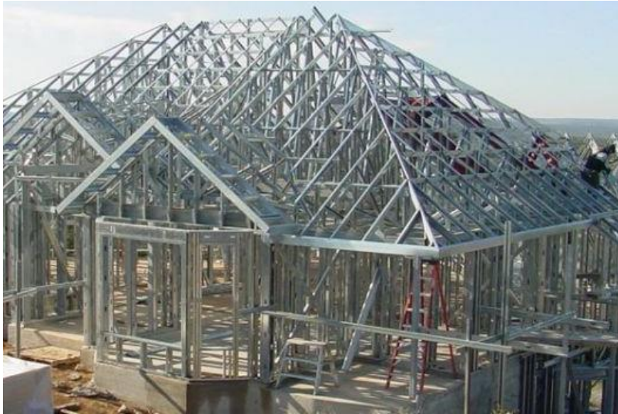
Figura 2 – Construção de Residência em Steel Frame
