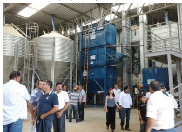
Figura 4 - Instalações da fábrica
