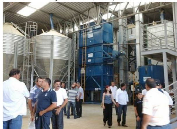
Figura 4 - Instalações da fábrica
